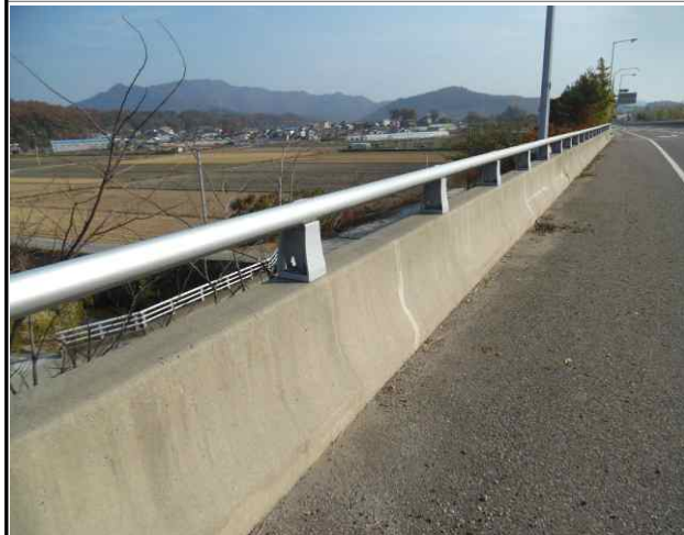
난간 및 연석 전경
